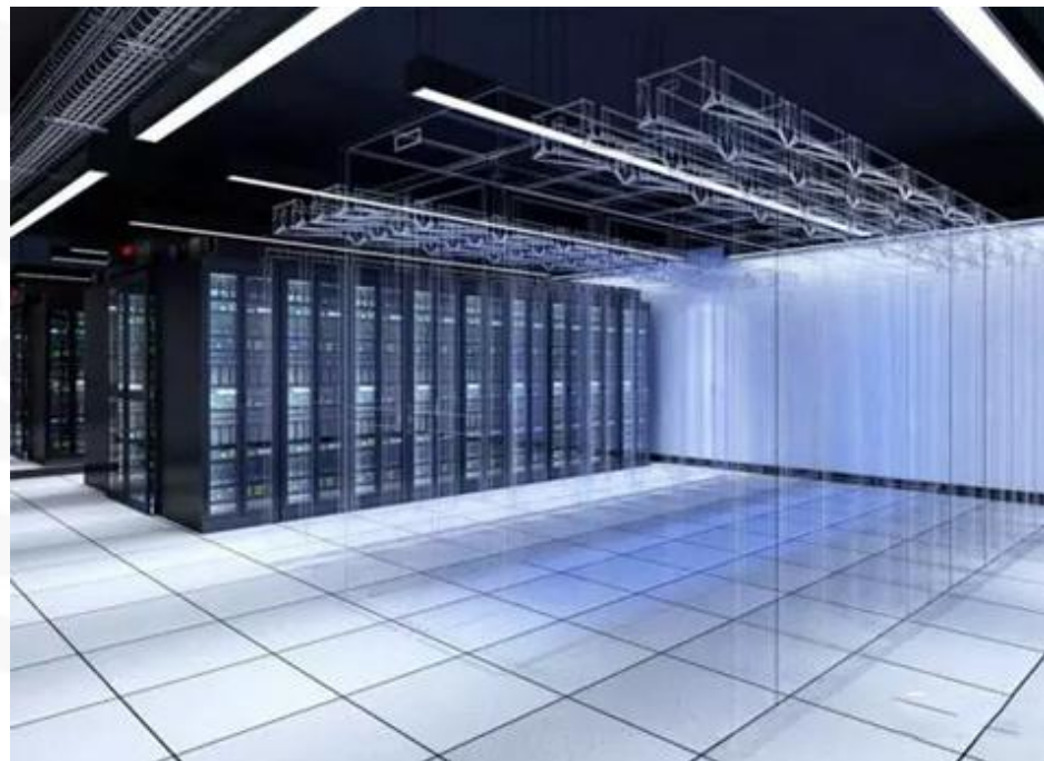
数据机房不间断电源
